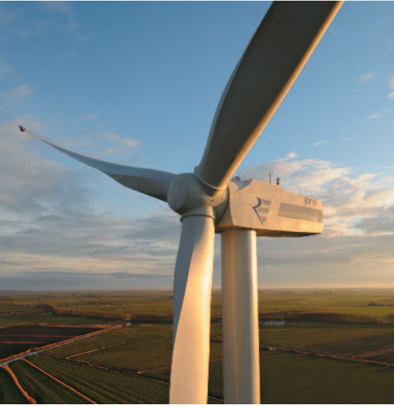
Standort Wittgeeste: Windenergieanlage REpower 3.4M104 mit einer Nabenhöhe von 128 Metern.
