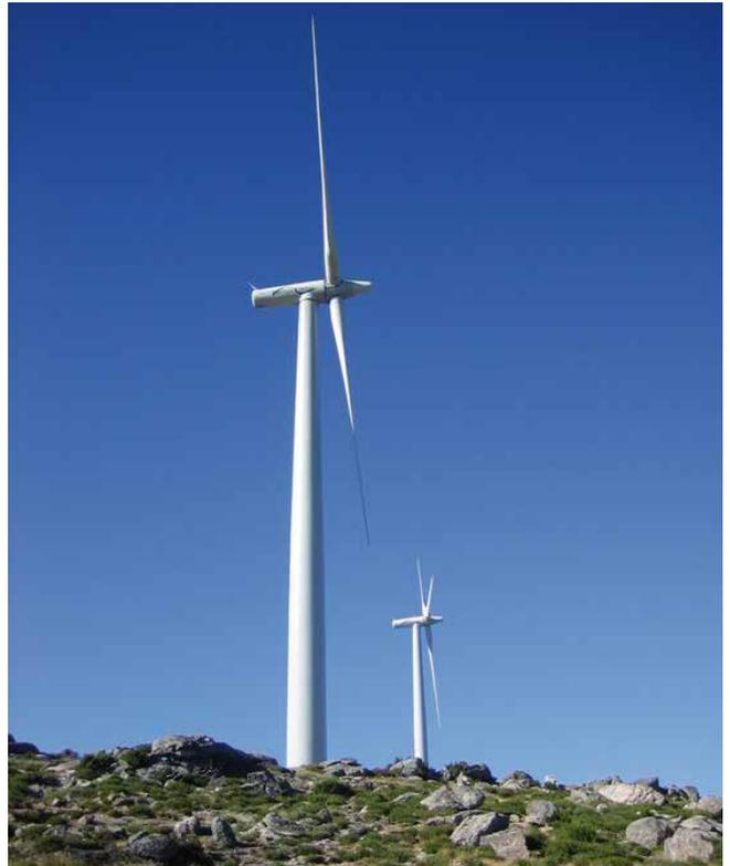
*Im Windpark Montemuro drehen sich seit August 2005 acht Windkraftanlagen mit einer Nennleistung von jeweils 1,3 Megawatt.*
