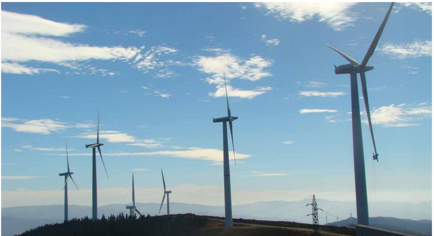
*Im Windpark Penedo Ruivo drehen sich seit Dezember 2005 zehn Windkraftanlagen mit einer Nennleistung von jeweils 1,3 Megawatt.*
